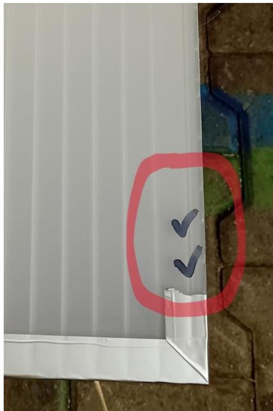
Abb. 38 Markierung der UV-beständigen Seite der Polycarbonatplatten.
