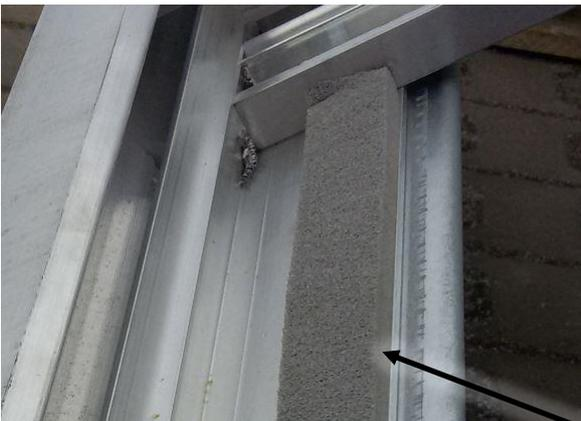
Nach dem Aufbringen expandiert die Schaumstoffdichtung auf N60 Profilen von 4 – 8 mm bis zu 25 mm und auf N80 Profilen von 7 – 12 mm bis zu 40 mm. Die Expansionszeit hängt stark von Wetterbedingungen ab. Hohe Temperaturen verkürzen die Ausdehnungszeit der Dichtung.
