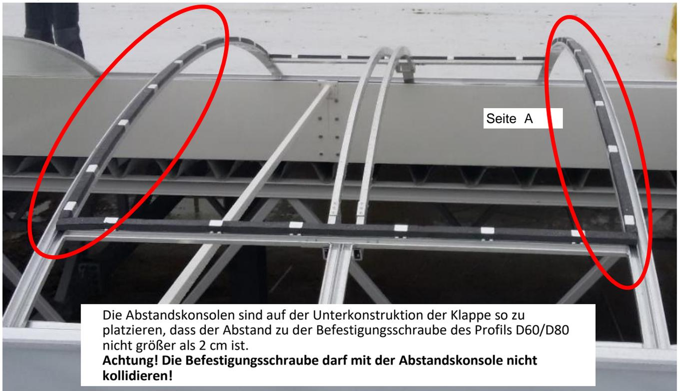
Abb. 46 Anordnung der Abstandskonsolen auf der Lichtbankklappen-Unterkonstruktion
