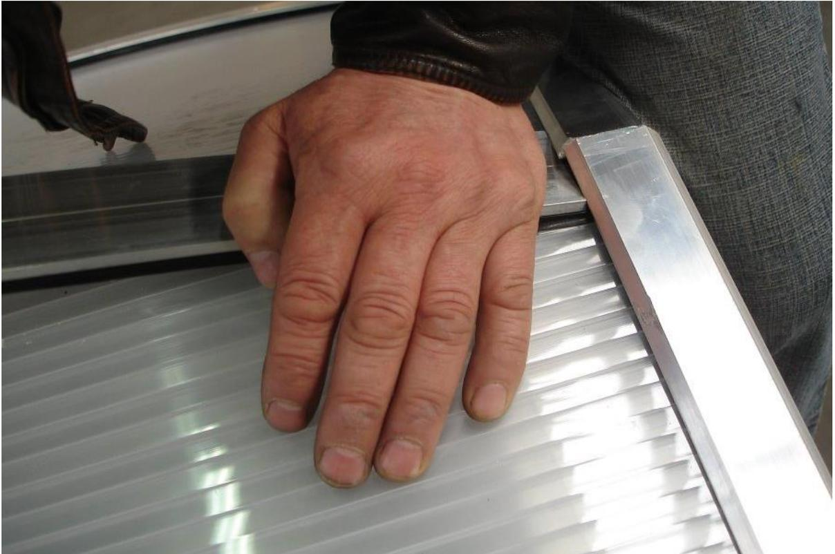
Sollten beim Eindrücken Probleme auftreten, kann das Abdeckprofil durch Biegen des Profilendes an die Form des Schlitzes angepasst werden.
