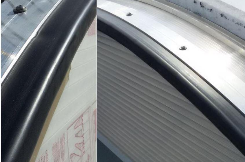
Die Kopfstück-Gummidichtung wird unter dem Abdeckprofil in der Montage mit der SIM-Dichtung montiert. Die Dichtungszunge überlappt die senkrechte Fläche des Kopfstücks.
