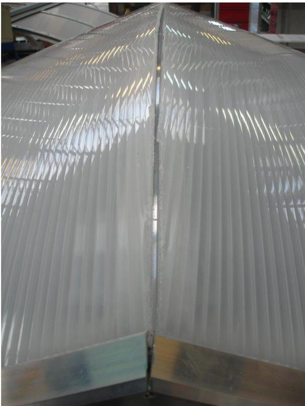
**Bei mehrschichtigen Verglasungen sind PC-Platten mit Abstandshaltern ausgerüstet.**
